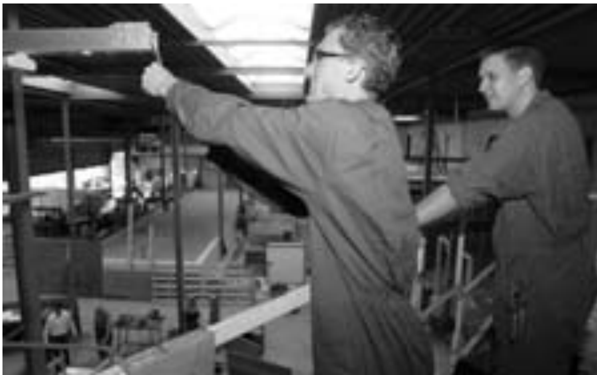
De productiehal van de nieuwe sapfabriek bij PTC+ aan de Edese Zandlaan in aanbouw. foto Henk van Holland
